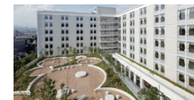
総合研修センター(屋上緑化)
