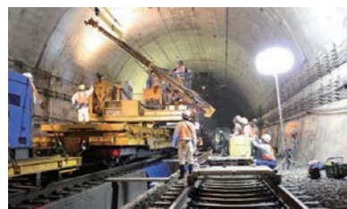
大規模改修工事
