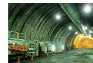
南アルプストンネル(山梨工区): 本線トンネルの掘削
