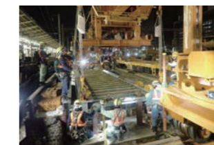
名古屋駅:工事桁の架設
