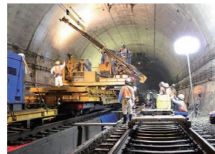
大規模改修工事
