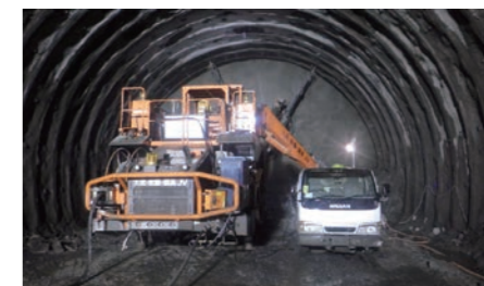
南アルプストンネル(山梨工区)における掘削工事
