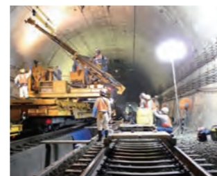
大規模改修工事
