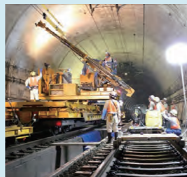
大規模改修工事
