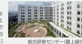
総合研修センター(屋上緑化)
