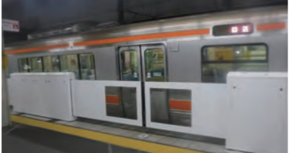
金山駅3番線への可動式ホーム柵設置
