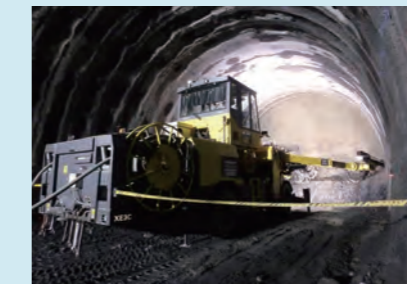
南アルプストンネル(山梨工区)
