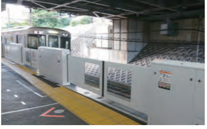
金山駅4番線への可動式ホーム柵設置
