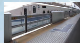
東海道新幹線全駅に可動柵を整備
