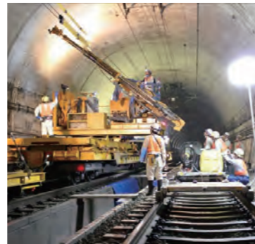
大規模改修工事
