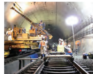
大規模改修工事
