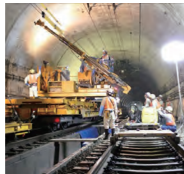
大規模改修工事
