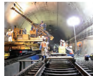
大規模改修工事
