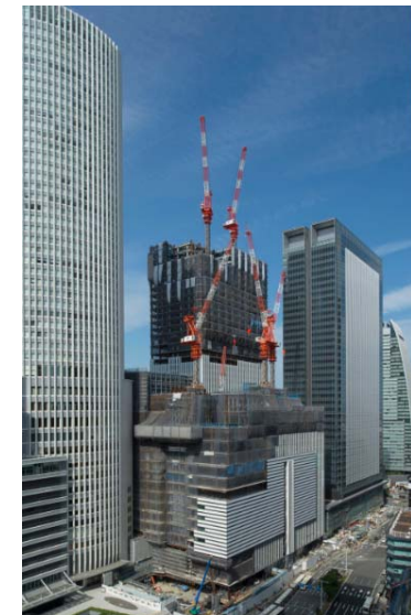
「JRゲートタワー」建設工事の様子 (平成27年9月29日撮影)
