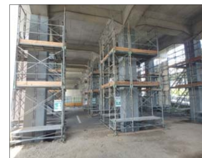
在来線高架橋柱耐震化(鋼板巻工法)
