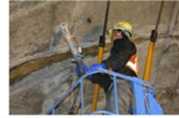
大規模改修工事(トンネル内覆工裏空疎充填)
