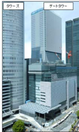
JRゲートタワー外観(平成28年4月撮影)
