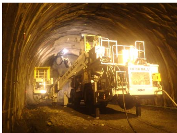
南アルプストーンネル(山梨工区)
