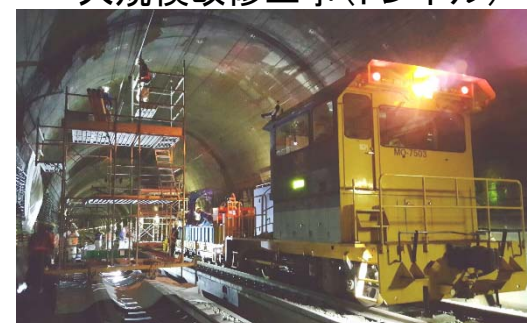
大規模改修工事(トンネル)
