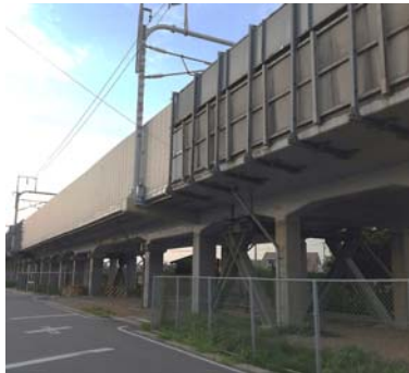
大規模改修工事(コンクリート橋)
