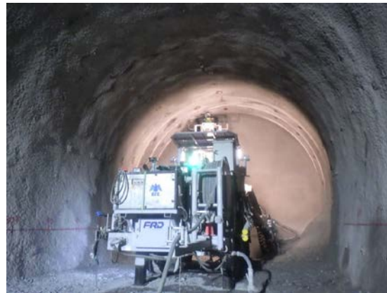
南アルプストーンネル（長野工区）
