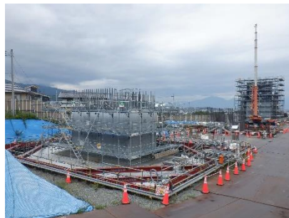
山梨県内高架橋
