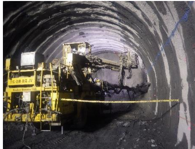
南アルプストーンネル (山梨工区)
