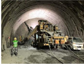
第四南巨摩トンネル（西工区）
