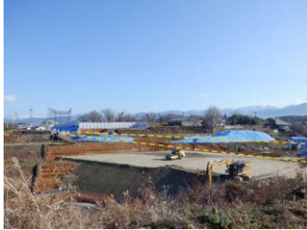
中部総合車両基地
