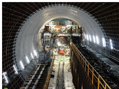
第一首都圏トンネル 北品川工区 シールドマシンによる調査掘進
