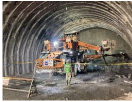
南アルプストーンネル（山梨工区） 本坑掘削
