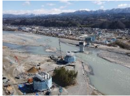
天竜川橋りょう 橋脚工
