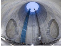
等々力非常口 立坑本体
