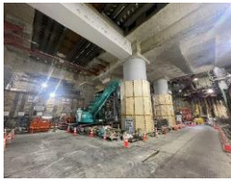
品川駅 軌道下掘削
