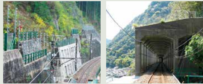
【落石止擁壁と落石警報装置】
